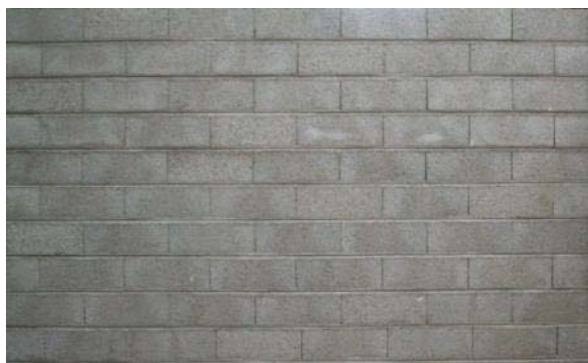
Obr. 1 – Zdivo z betonových skořepinových tvárnic
