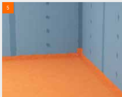
5 Celoplošné utěsnění povrchu v oblasti W1-I.
