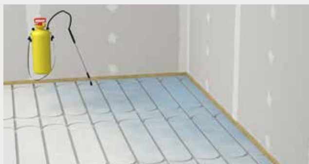
Aplikace hloubkové penetrace fermacell® na fermacell® Therm25.
