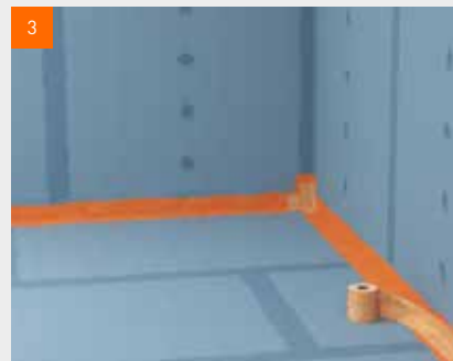
3 Zatlačte těsnící pásku fermacell™ do vlhké tekuté fólie.
