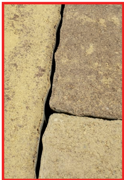
CHYBNĚ pokládka kamenů na sraz
