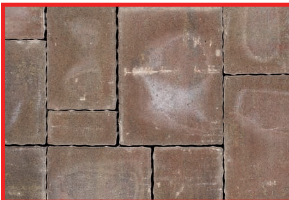
případný výskyt vápenného výkvětu během zrání betonu
