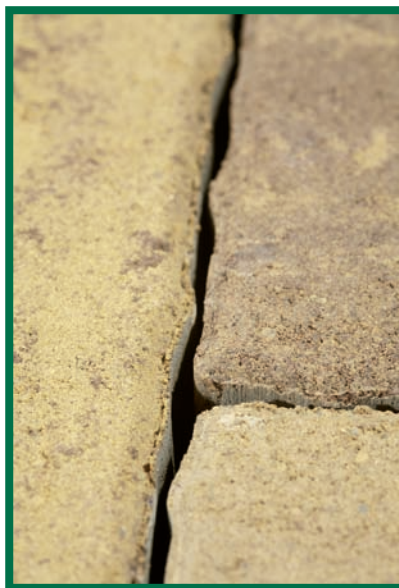
SPRÁVNĚ (PŘED ZAPÍSKOVÁNÍM) dodržena spára 3 - 5 mm
