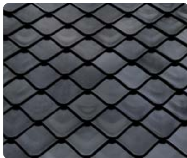
pokládka na vazbu
