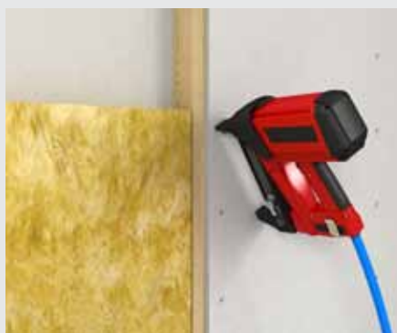
Opláštění dřevěné spodní konstrukce pomocí sponek
