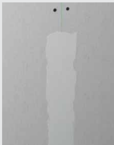
Částečně provedené jemné tmelení
