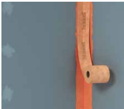
Obrázek 2: Těsnící páska fermacell se vtlačí do nanesené ještě vlhké tekuté fólie fermacell a ihned se tekutou fólií přetře, doba schnutí: min. 1 hodina
