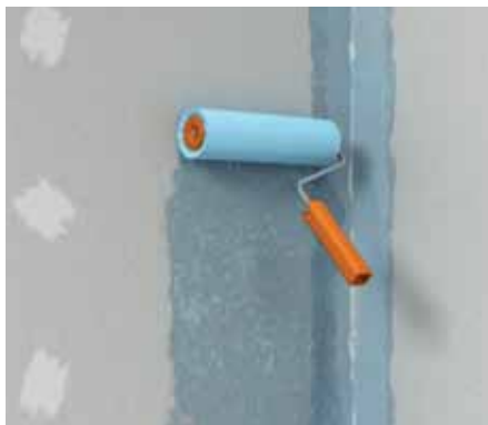
Obrázek 1: Celoplošný nátěr hlubkovou penetrací fermacell , doba schnutí: min. 2 hodiny
