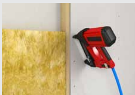
Upevňování sponkami na dřevěnou spodní konstrukci
