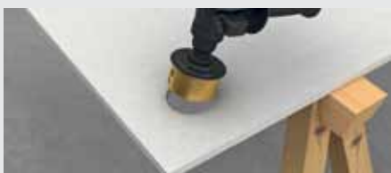
Vrtání otvorů pro zásuvky
