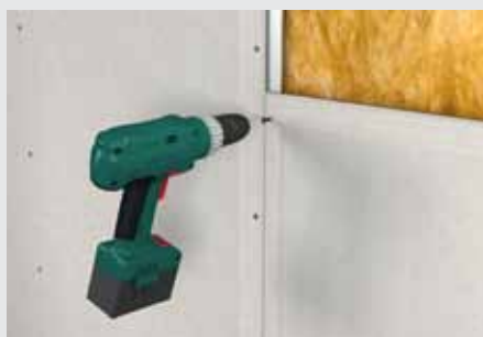
Šroubování na kovovou spodní konstrukci
