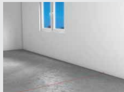
Vyznačení osy stěny provázkem nebo stavebním laserem
