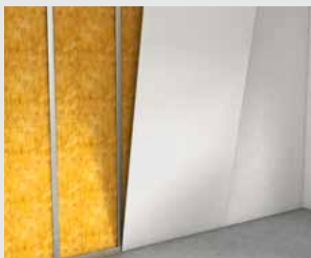
Opláštění kovové spodní konstrukce
