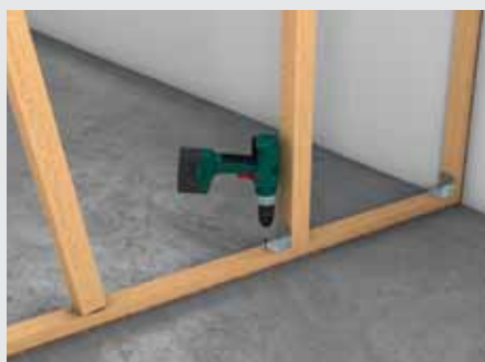
Montáž spodní konstrukce hmoždinkami nebo kovovými úhelníky
