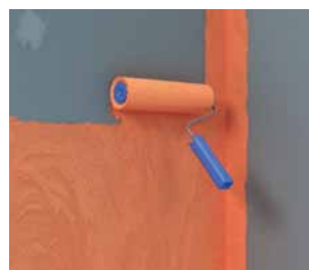
Obrázek 4: Tekutá fólie fermacell se nanáší celoplošně válečkem ve dvou vrstvách (celková tloušťka \geq 0,5 mm), doba schnutí: min. 2-3 hodiny
