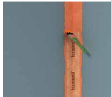
Obrázek 2: Těsnící páska fermacell se vtlačí do nanesené ještě vlhké tekuté fólie fermacell a ihned se tekutou fólií přetře, doba schnutí: min. 1 hodina
