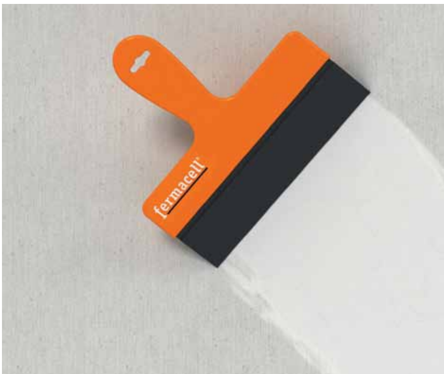
Plošné stěrkování sádrovláknitých desek fermacell
