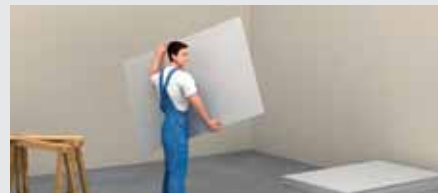
Jednotlivé sádrovláknité desky fermacell se přenášejí na stojato
