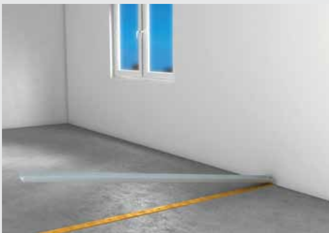
Upevnění vodícího UW profilu na izolační pásku na podlaze
