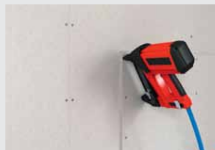
Upevňování desek fermacell na desky fermacell sponkami
