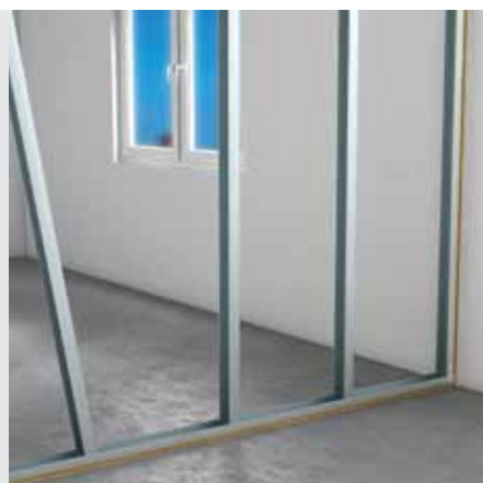
Montáž stojin z CW profilů
