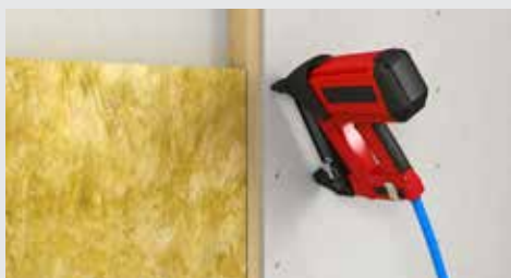
Upevňování sponkami na dřevěnou spodní konstrukci
