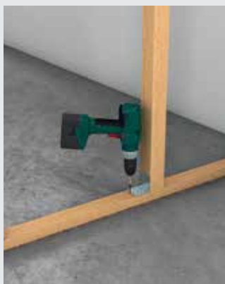
Montáž spodní konstrukce hmoždinkami nebo kovovými úhelníky
