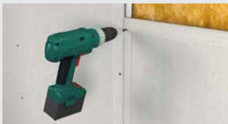
Šroubování na kovovou spodní konstrukci
