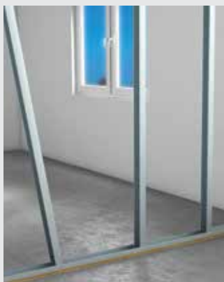
Montáž stojin z CW profilů
