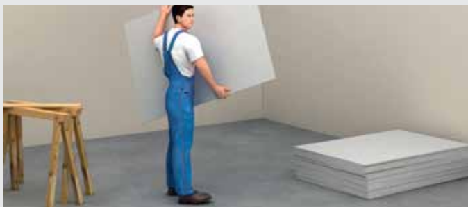
Skladování sádrovláknitých desek fermacell
