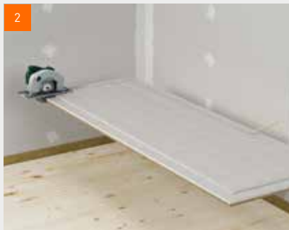
2 Odříznutí přesahující polodrážky pro první řadu podlahových prvků
