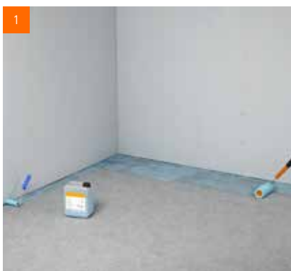
1 Příprava podkladu hloubkovou penetrací fermacell™
