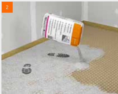
Vyplnění voštiny voštinovým zásepem fermacell™
