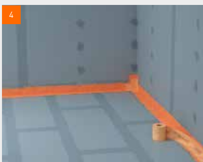
4 Do vlhké tekuté fólie vtlačte těsnící pásky fermacell™
