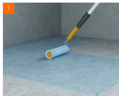
Příprava: penetrace podlahy
