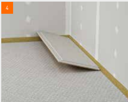
Pokládka podlahových prvků fermacell®
