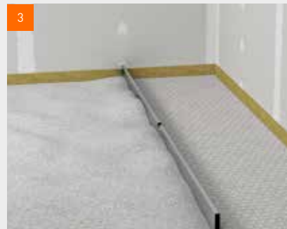
Zarovnání voštinového zásepů fermacell™
