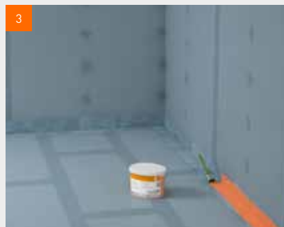
3 Tekutou fólii fermacell™ nanášejte v rozích pomocí štětce
