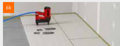
Fixace pomocí šroubů nebo speciálních rozpěrných sponek... vše do deseti minut po nanesení lepidla.
