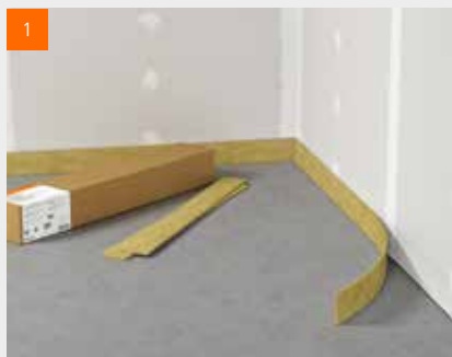
Upevnění okrajových izolačních pásek
