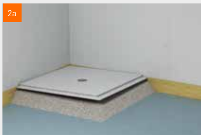
Varianta 1a: ve výši horní hrany korpusu odtoku je celá plocha pokryta rychlotuhoucím podsypem T a poté usazen sprchový prvek
