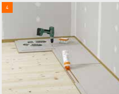
4 Nanášení podlahového lepidla fermacell™ na polodrážky
