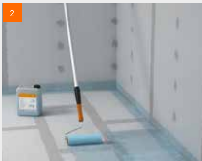
2 ... a pomocí válečku potom také na podlahu
