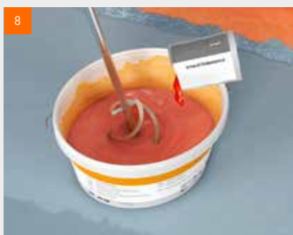
8 2. nátěr: přibalení pigment se dobře rozmíchá a tónovaná tekutá fólie fermacell™ se nanese v požadované vrstvě min. 0,5 mm. U druhé vrstvy nátěru doporučujeme změnit směr nanášení, např. Kolmo na první vrstvu. Detailní informace k produktu najdete v Technickém listu.
