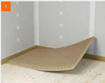
Pokládka podlahové voštiny fermacell™
