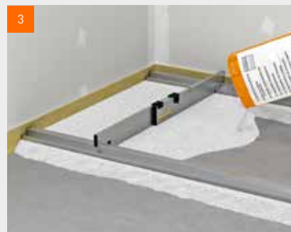
Aplikace vyrovnávacího podsypu
