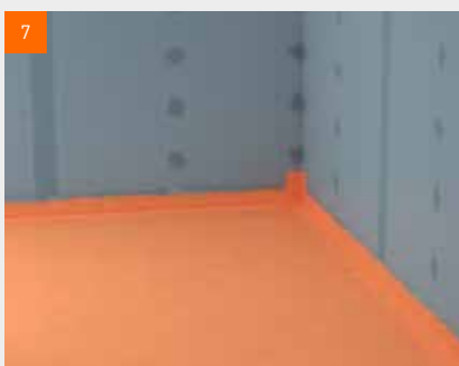
7 Při použití sádrovláknitých podlahových prvků ve třídě W 1-I je nutná celoplošná aplikace těsnícího systému. Tekutá fólie fermacell™ se nanáší ve dvou vrstvách válečkem při tl. vrstvy nátěru min. 0,5 mm. Pro druhý nátěr se přibalení pigment, který je součástí balení tekuté fólie fermacell™ dobře rozmíchá v odpovídajícím množství tekuté fólie. 1. nátěr: aplikace tekuté fólie fermacell™ bez přidaného pigmentu a následné proschnutí
