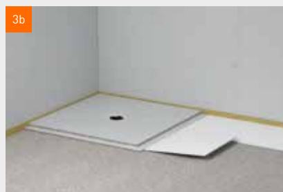
Varianta 1b: kolem sprchového prvku je ve výši přesahujícího stupně nasypána cca 200 mm široká hráz jako základ pro stažení zbývajících ploch
