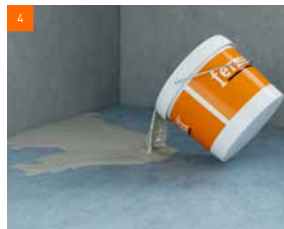
Nivelační hmotu vylijte a vyrovnajte
