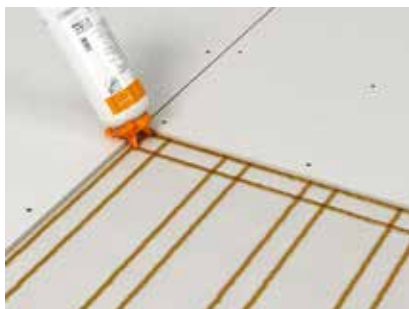
K zajištění dokonalého prolepení hran desek třetí vrstvy se lepidlo nanese také podél hrany sousední desky
