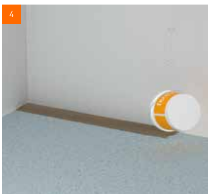
4 Připraví se první břeh pro stahovací lať
