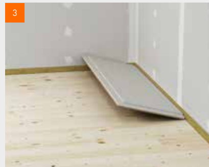
3 Založení prvního podlahového prvku fermacell®
