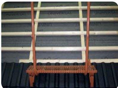
Obr. 12 Připevnění stojek zábradlí
