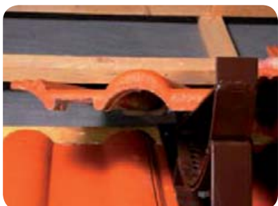
Obr. 7 Drážka v tašce pro překrytí háku
