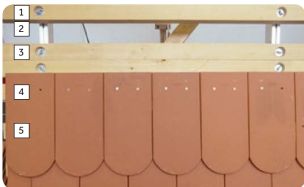
Obr. 10 - Popis k obrázku (vzdálenost latí je 145 mm) 1 - střešní lať, 2 - mezilať, 3 - střešní lať, 4 - střešní lať, 5 - střešní lať
