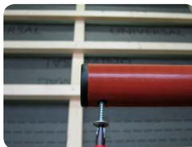
Obr. 16 Krytky a jejich zajištění
