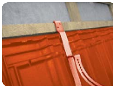
Obr. 9 Připevnění závěsného háku
