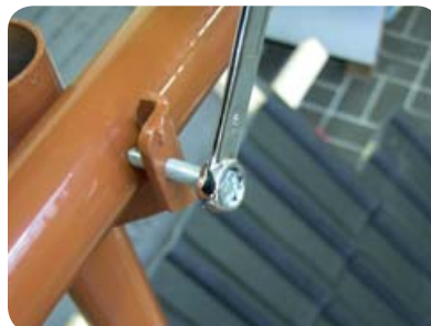
Obr. 15 Upevnění vodorov- ných tyčí zábradlí
