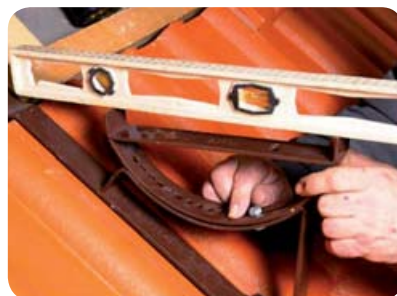
Obr. 4 Kontrola horizon- tální polohy držáku
