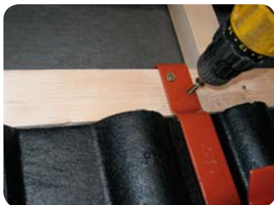
Obr. 3 Upevnění háku k mezilaťi
