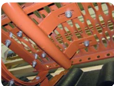
Obr. 13 Připevnění stojek zábradlí pomocí čtyř šroubů
