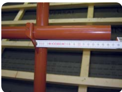
Obr. 14 Kontrola polohy vodorovných tyčí zábradlí
