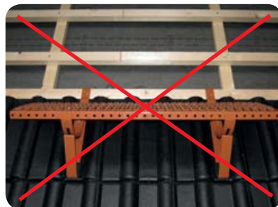
Obr. 1 Vzdálenost mezilatě 85 mm
